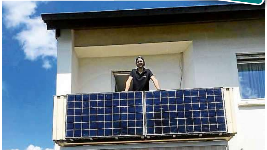
Filderstadt unterstützt die Energiewende und finanziert für zwei Miet-Haushalte jeweils eine kleine Photovoltaik-Anlage, die am Balkon angebracht werden kann. Fotos: Teckwerke Bürgerenergie e.G.
