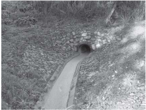
Teilsanierung Oberflächenwasserfassung nach Fertigstellung im Jahr 2008: Graben an der Deponiestraße im Norden – Grabenausbau mit Betonsohlschalen
