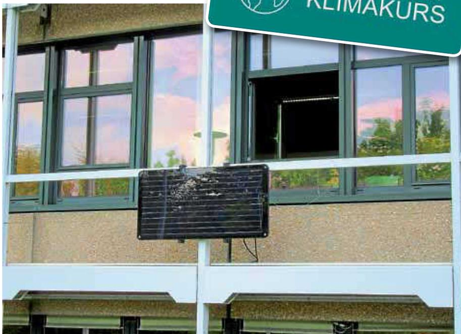
Ganz einfach am Haus zu montieren – die Mini-Solaranlage.
