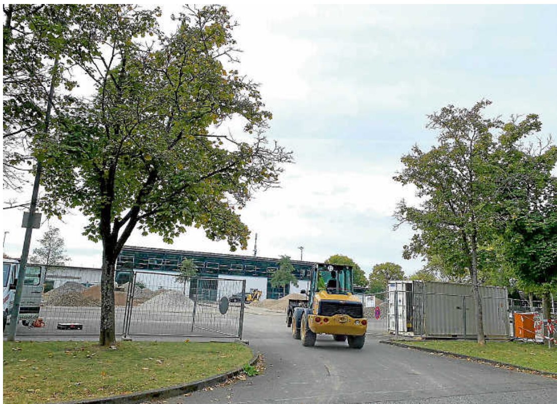
Die Vorbereitungen in Plattenhardt laufen auf Hochtouren.
