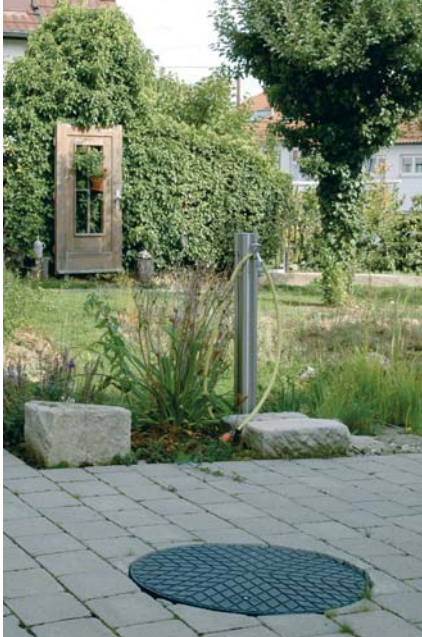
Regenwasserzisterne mit Zapfsäule, Foto: Birgit Förderreuther
