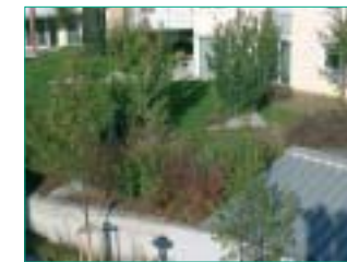
Intensive Dachbegrünung auf einer Tiefgarage in Bonlanden
