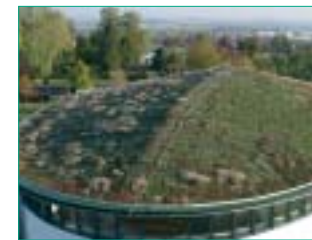
Extensive Dachbegrünung auf der neuen Sielminger Aussegnungshalle
